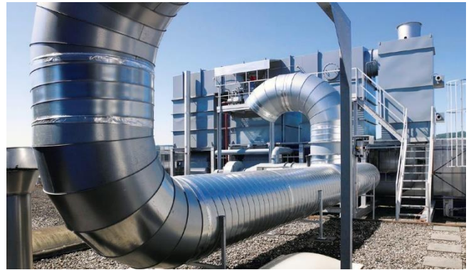
Regenerative Nachverbrennungsanlage
