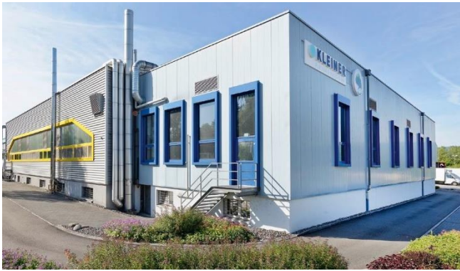
Produktionsgebäude der O. KLEINER AG
